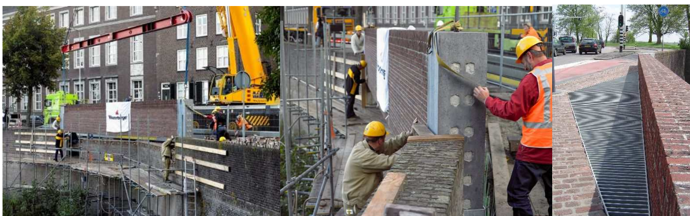
Links 2 foto's van het plaatsen van de balk op zondagochtend 2 oktober 2005 en rechts het eindresultaat.
